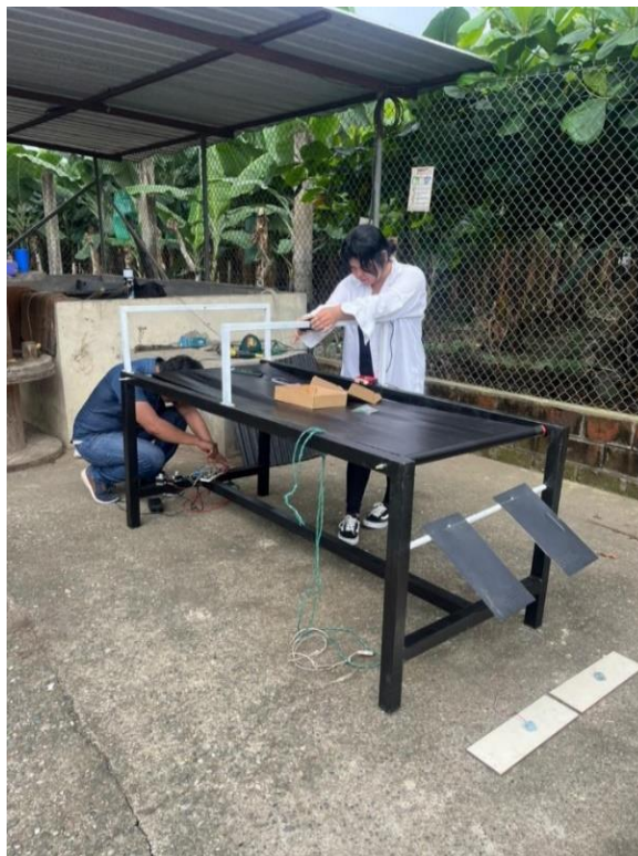
Figura 9. Construcción del prototipo
